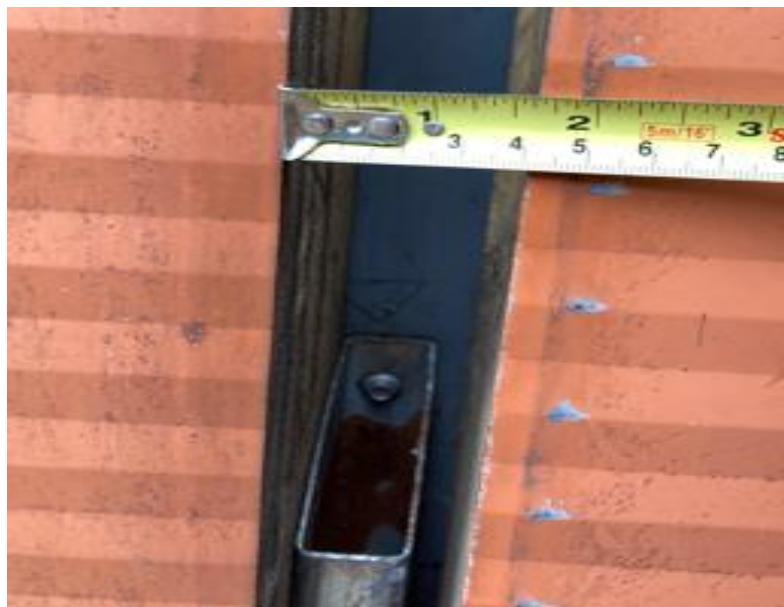
Foto 7: Medida da espessura do espaço entre colunas de painéis a ser arrematada
