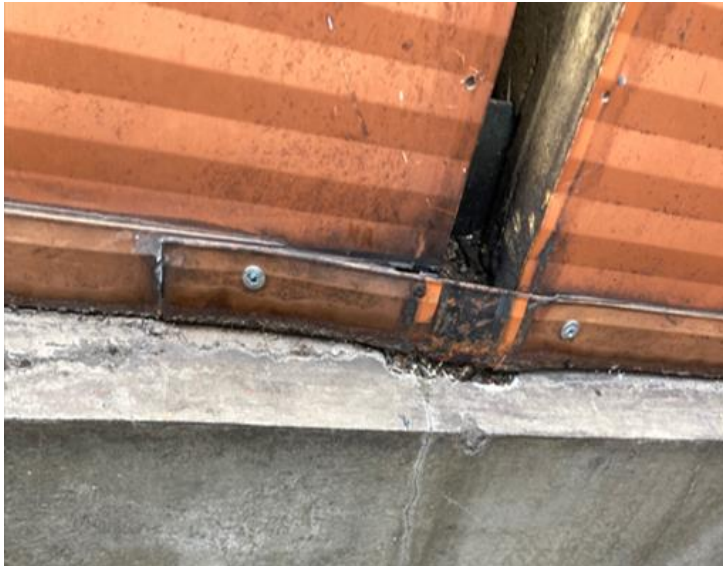
Foto 14: Detalhe da ausência de arremate
