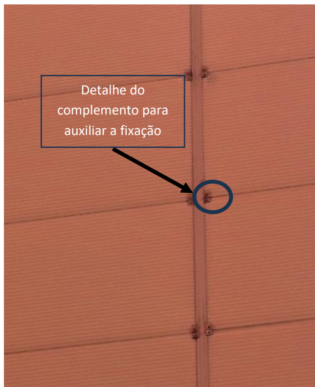
Figura 5 - Detalhe da arruela fabricada para auxílio da fixação
